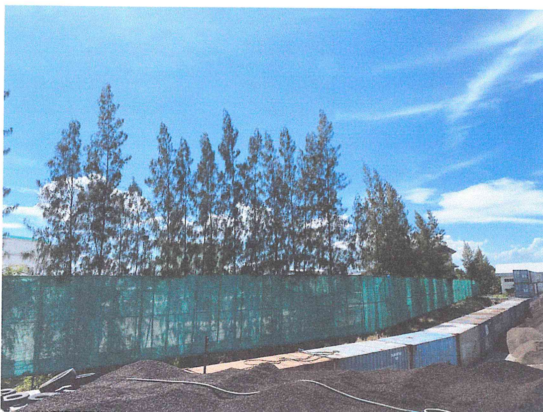
ภาพที่ 8 มีการชิงสแลนและปลูกต้นไม้ตลอดแนวเพื่อเป็นการดักจับฝุ่นละออง
