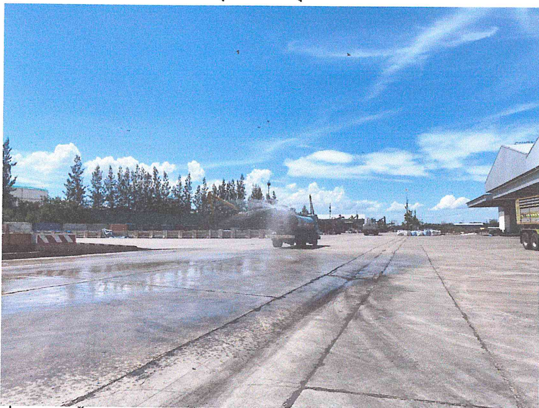
ภาพที่ 4 ใช้รถน้ำปล่อยสเปรย์น้ำลงบนพื้นถนนบริเวณหน้าโกดังเก็บสินค้าเพื่อลดการฟุ้งกระจายของฝุ่นละออง ทุก 1-2 ชั่วโมง/ครั้ง
